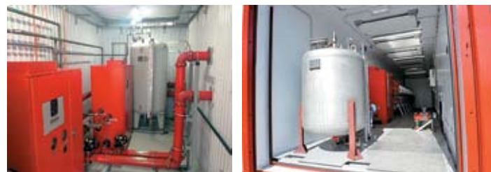
Рис 2. Примеры СППТ (станция пенного пожаротушения) в блочно-модульном исполнении
